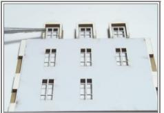
Découper aux dimensions la feuille de plastique transparent des vitrages et appliquer sur la face intérieure (non gravée) des huisseries avec la colle à bois. Coller les ensembles obtenus depuis l'intérieur du bâtiment.
