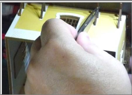
Mettre en place les éléments de charpente en les maintenant le temps de la prise.
