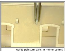
que les parements, mettre en place les supports de charpente en les maintenant le temps de la prise.
