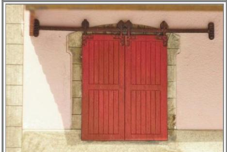
**9** Après peinture des portes et des coulisses métalliques, mettre en place les portes de halle par l'extérieur.
